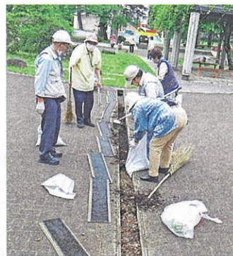
落葉や泥の撤去作業
