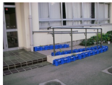
写真 1 出入口にスロープを設置 (第七小学校)
