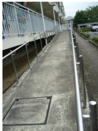
写真2 出入口のスロープ① (下田団地)
