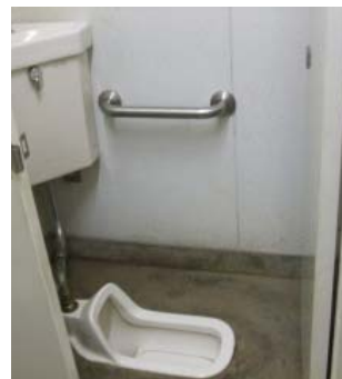
写真1 一般トイレに 手すりを設置 (グランド管理棟)
