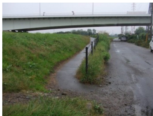
写真3 車道からグランドまで行く ためのスロープ (グランド管理棟)
