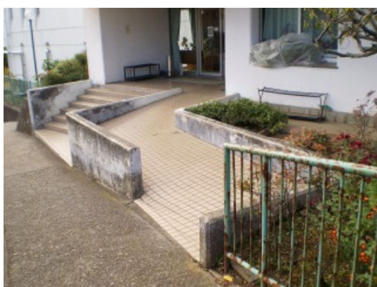
写真1 出入口にスロープを設置① （湯沢福祉センター）
