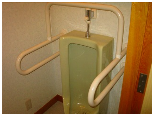
写真7 小便器に手すり設置 (豊田下地区センター)
