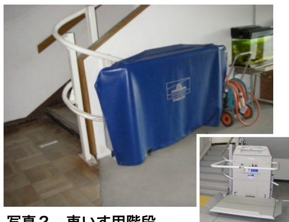
写真 2 車いす用階段昇降機を設置 (七生緑小学校) (第四小学校)
