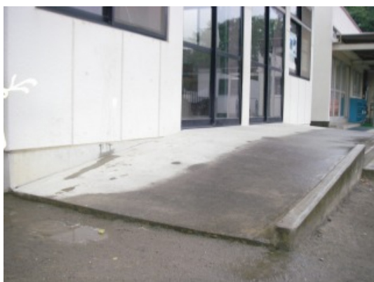
写真1 出入口にスロープを設置 （第五幼稚園）
