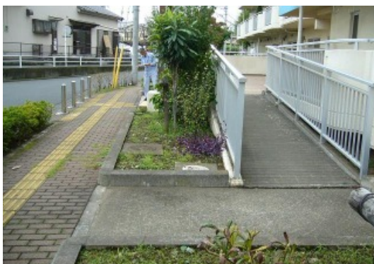
写真3 出入口のスロープ② (高幡団地 2 号棟)
