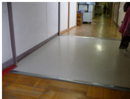
写真3 段のある廊下にスロープを設置 （とよだ保育園）
