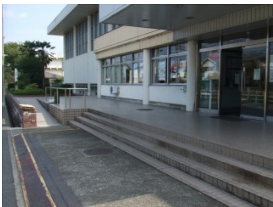
写真4 出入口にスロープを設置① (南平体育館)
