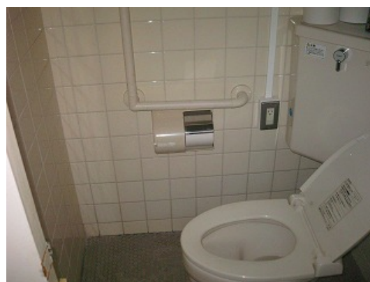
写真6 一般トイレに手すり設置 (落川地区センター)
