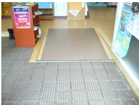
写真2 出入口にスロープを設置 （あさひがおか保育園）
