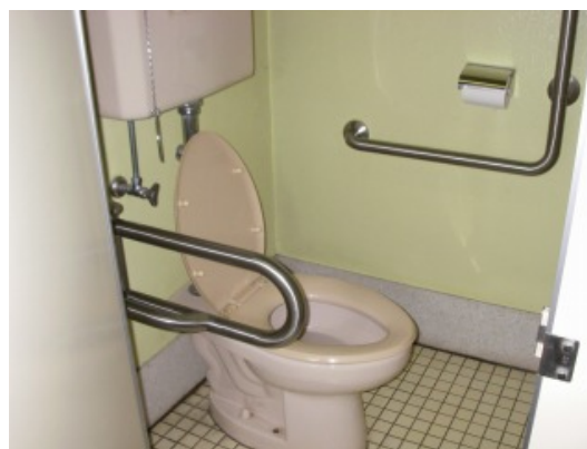
写真2 一般トイレに手すりを設置 （第七幼稚園）
