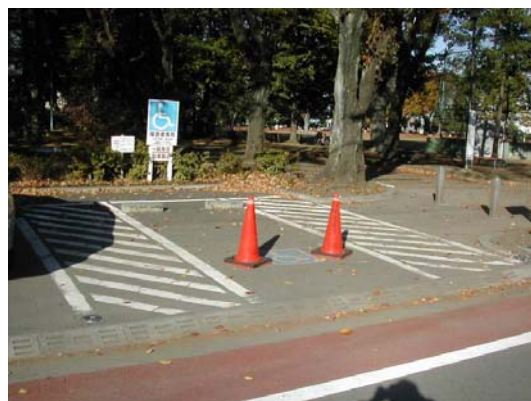
写真2 公園の出入口② (旭が丘中央公園駐車場)
