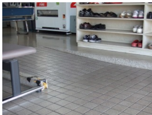
写真5 出入口にスロープを設置② (南平体育館)
