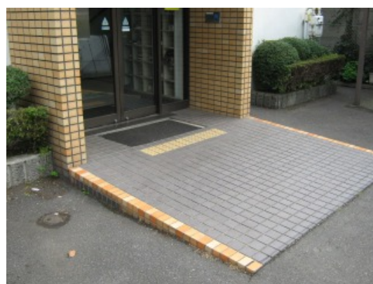
写真2 出入口にスロープを設置② （はくちょう）
