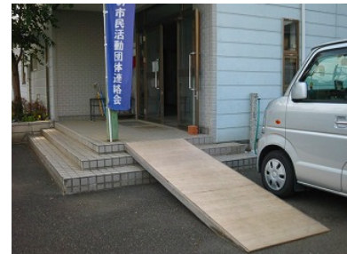
写真1 簡易型スロープを設置 (仮称)市民活動支援センター)
