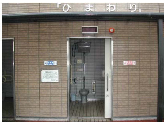
写真1 だれでもトイレ入口
