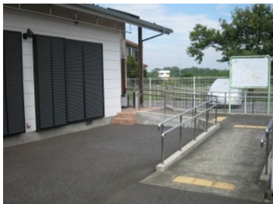
写真3 建物出入口の段差解消 (東光寺東地区センター)
