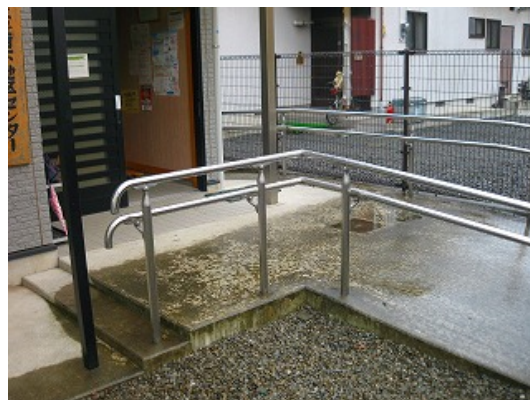
写真4 建物出入口の段差解消 (豊田下地区センター)
