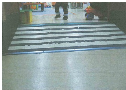
写真2 部屋の入口にある段に スロープを設置 (まんがんじ児童館)
