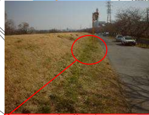
②浅川処理場正面入口前
