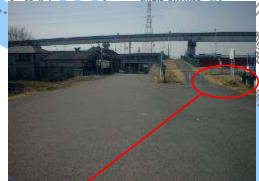
④立日橋南詰（下流側）
