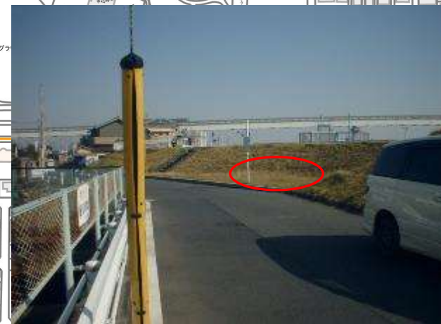
⑤下水排水樋管付近
