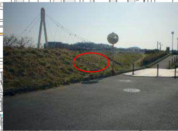
④万願寺歩道橋北詰
