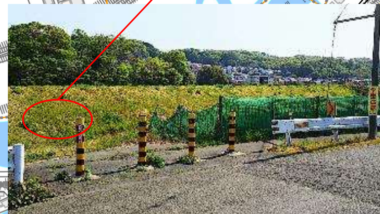
④滝合橋北詰上流車止め付近
