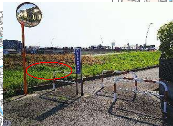
③高幡橋北詰下流側
