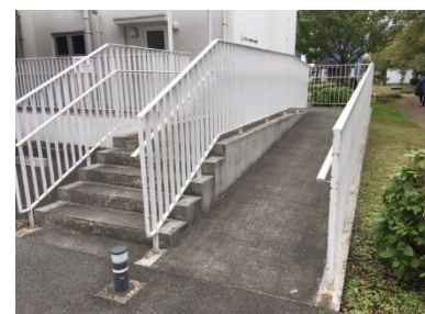
階段の脇に整備されたスロープ
