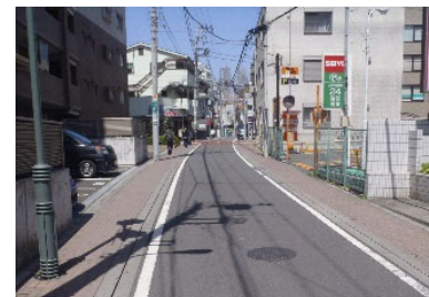
カラー舗装で歩行者の安全性が向上した単断面道路
