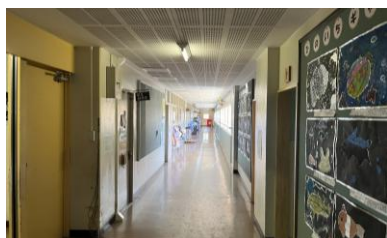
校舎廊下の内観
